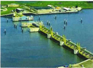
Ems Sperrwerk bei Gandersum, ca. 41 km
